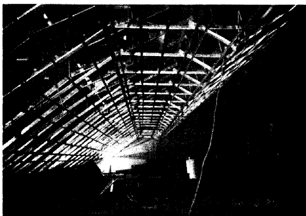
Photo 6 大ホール客席天井軽鉄組み状況
