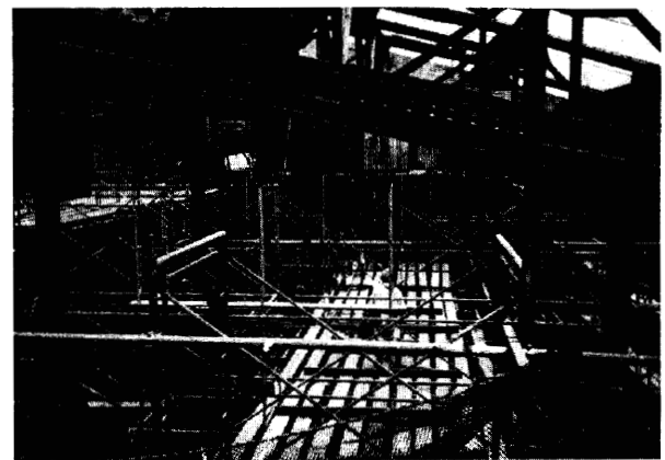
Photo 4 センタースポット室の組立て状況
