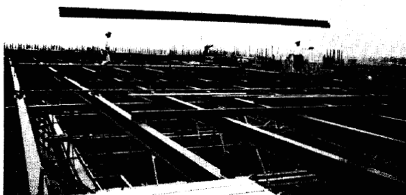
Photo 2 ブドウ棚鉄骨の組立て
