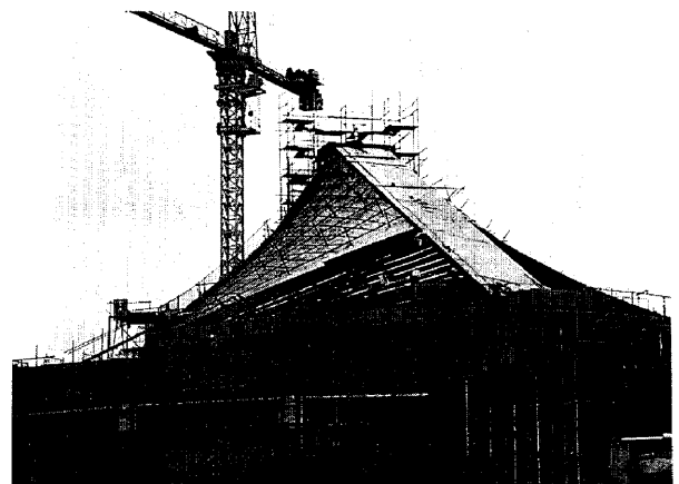
Photo 5 トンボクレーンによる外部仕上工事
