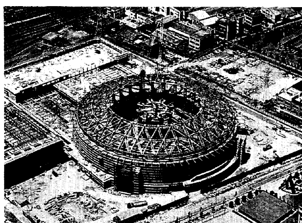
Photo 2 外周大梁建方完了
