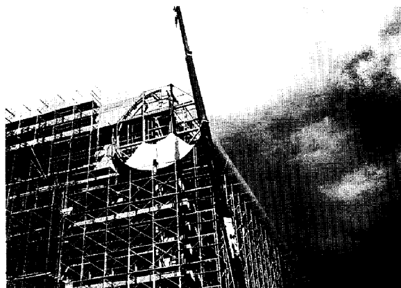
Photo 6 ENDパネルの取付
