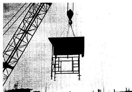
Photo 7 梁・スラブユニット型枠建込み
