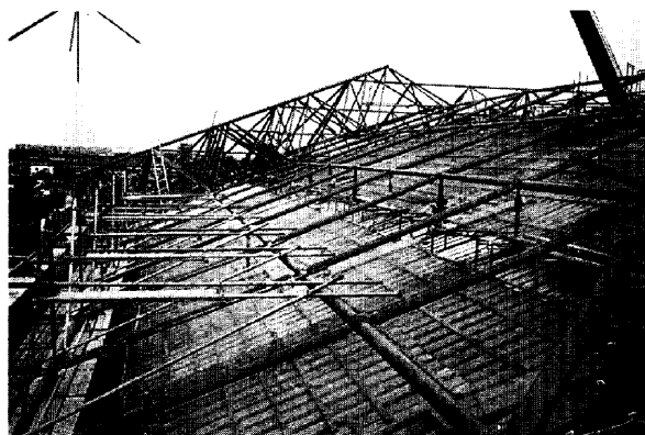
Photo 4 立体トラス組立作業(仮受支保工)
