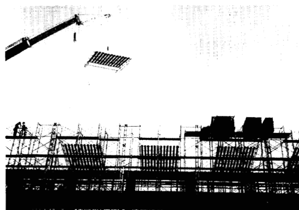
Photo 2 ユニット化作業床取付作業
