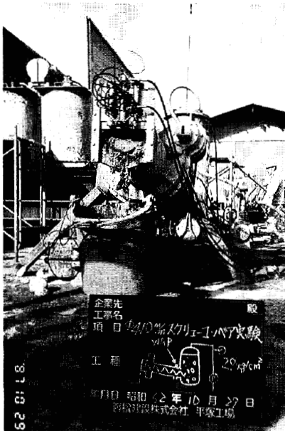
Photo 4 2.0kg/cm 2 加圧時の排土状況
