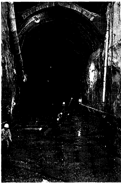
Photo 1 減勢庭掘削完了状況
