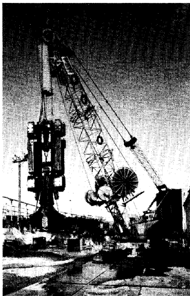
Photo 2 連壁掘削工(MHL)
