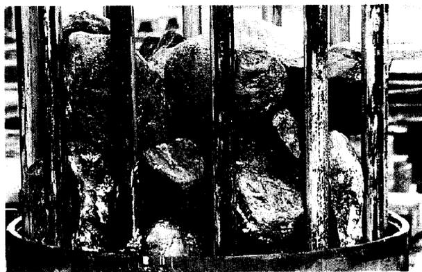
Photo 4 ウォータージェット引き上げ時にパイプと一緒に引き上げられた転石
