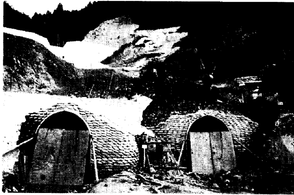
Photo 2 北坑口側から見た側壁導坑
