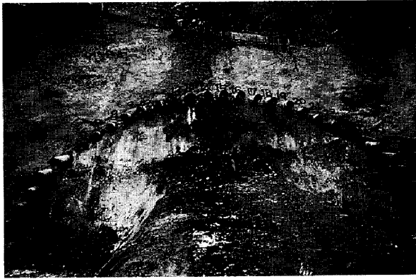
Photo 8 パイプルーフ施工完了全景
