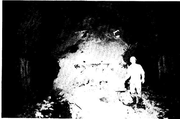
Photo 3 坑内側から見た側壁導坑
