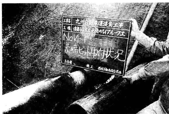
Photo 4 先端ビット取付状況
