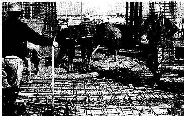
Photo 10 梁スラブコンクリート打設
