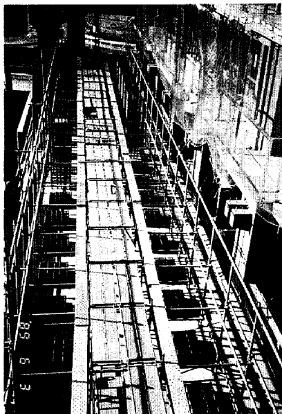
Photo 13 柱鉄筋先組ヤード
