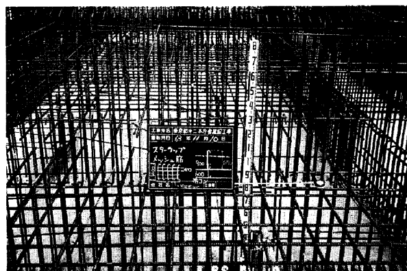
Photo 4 耐圧盤上筋と2段目のメッシュ筋の状況
