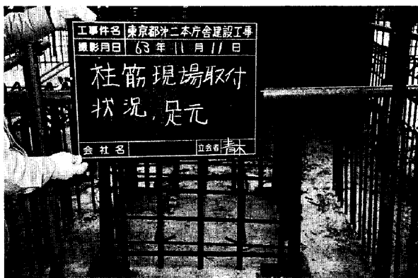
Photo 7 柱筋下端部の状況
