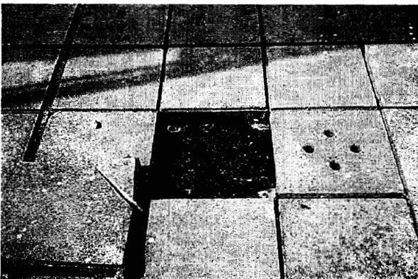
Photo 3 屋上泥等の堆積
