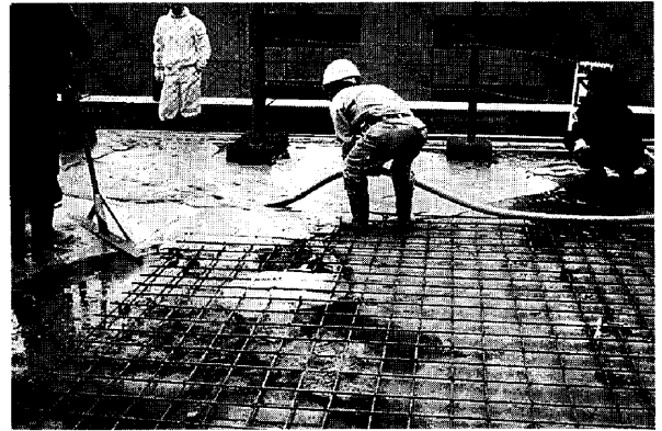
Photo 6 気泡コンクリート打設
