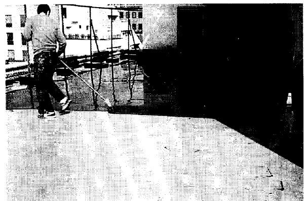
Photo 7 屋根面エポキシ塗布作業
