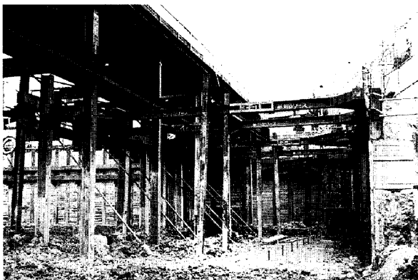
Photo 2 上段アンカー打設状況(下段切梁架設前)
