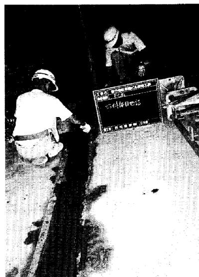
Photo 4 接合部のモルタル充填状況
