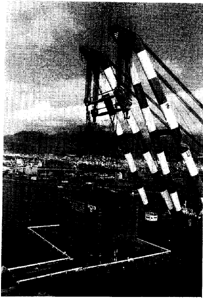
Photo 1 鋼製ケーソン吊込状況
