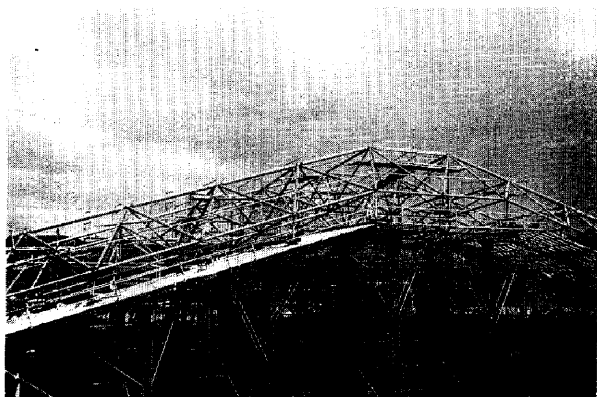
Photo 6 移動構台による立体トラス組立状況
