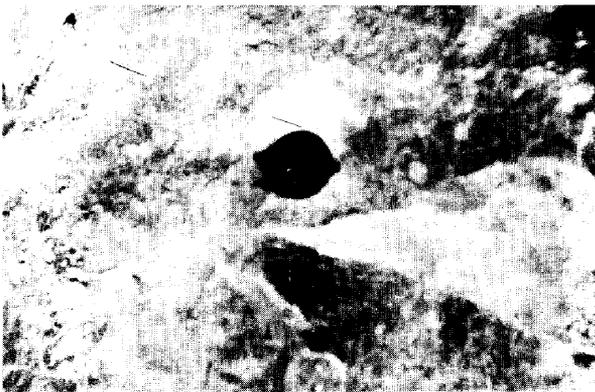
Photo 2 ウイングビットにより削孔された孔
