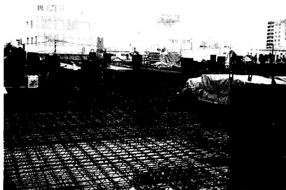
Photo 1 ファブデッキ敷込み状況
