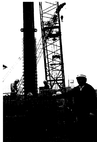
Photo 3 構真柱建込み状況
