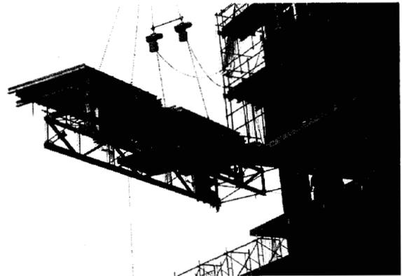
Photo 5 大型型枠盛替状況
