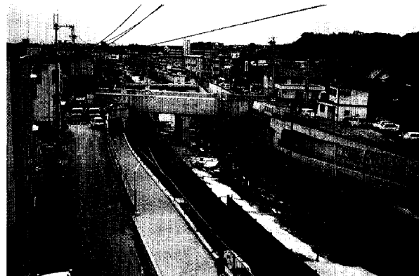
Photo 1 二次施工・軌道下底盤コンクリート打設後
