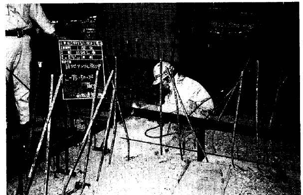
Photo 1 フラットバー施工状況
