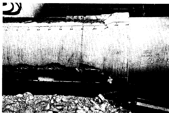
Photo 2 鉄筋コンクリート管破碎状況
