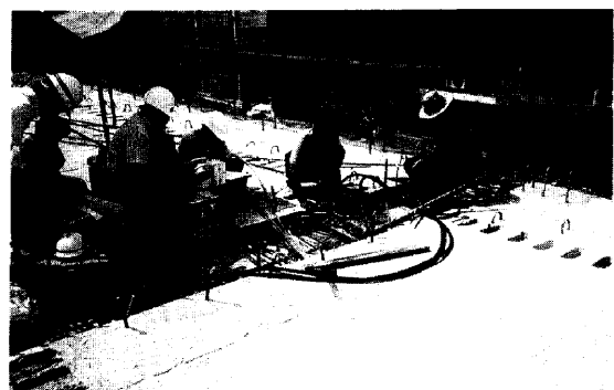
Photo 4 プレストレスの導入状況(橋軸方向)
