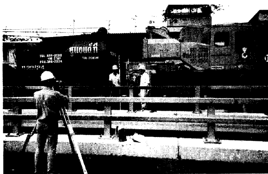
Photo 10 実橋載荷試験の状況
