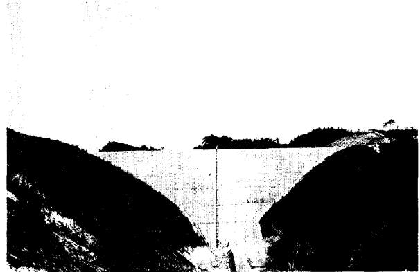
Photo 7 試験盛土 (完了全景)
