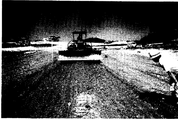
Photo 2 タンピングローラによる転圧状況
