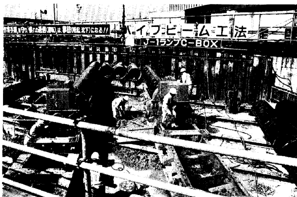
Photo 2 ルーフパイプ圧入状況
