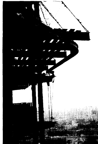
Photo 7 カーテンウォール取付用走行式チェーンブロック
