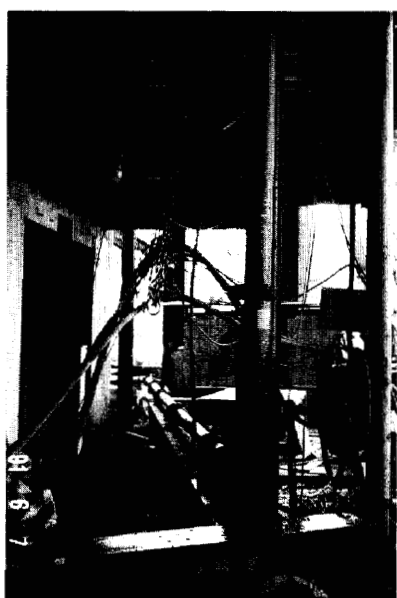
Photo 2 水平配管立上がり部状況
