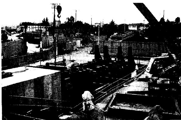
Photo 2 函体推進状況
