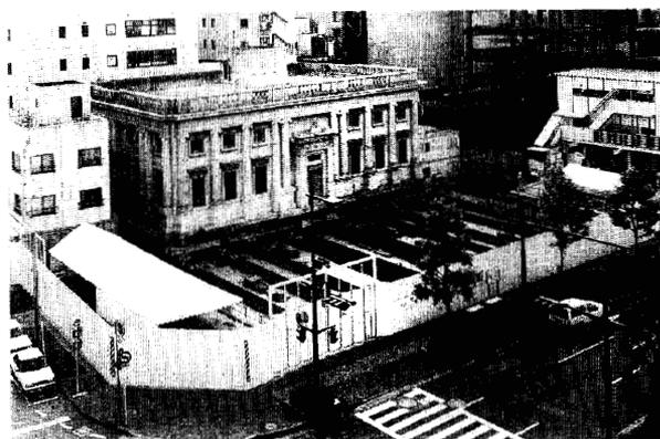
Photo 2 曳家工事完了。移動距離は24.5m
