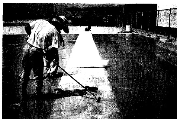
Photo 2 ウレタン防水の上, FRP防水の施工 (白い帯はガラスクロス)
