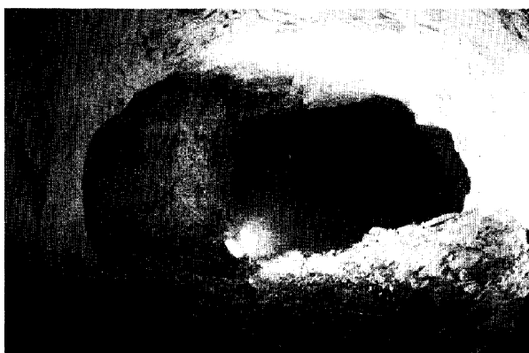
写真-1 空洞内状況
