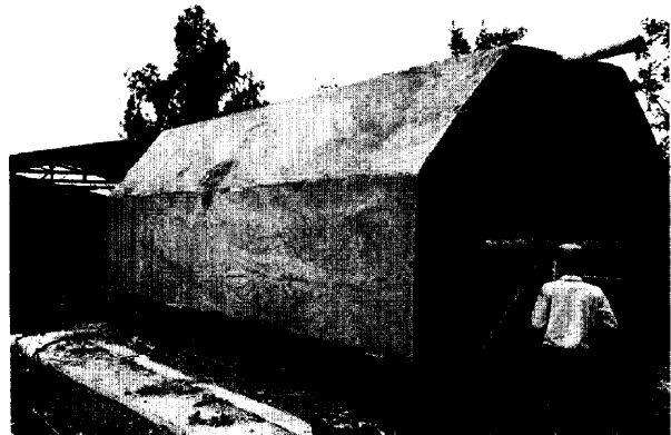
写真-2 モルタル充填状況
