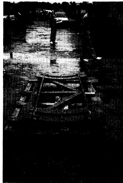
写真-3 鋼管運搬台車
