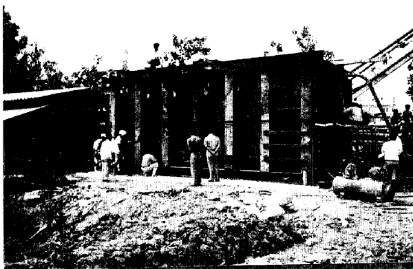
写真-1 鋼管外圧現場試験状況
