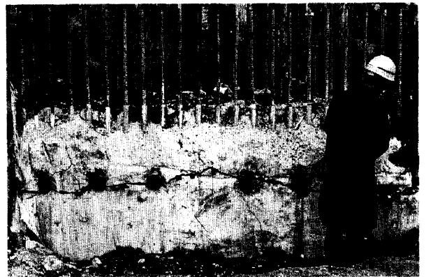
写真-2 破碎状況
