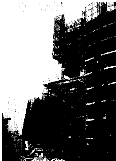
写真-1 ユニット足場クライミング
