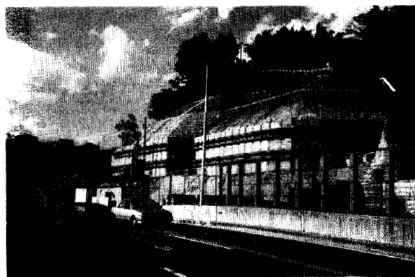
写真-2 山留工全景
