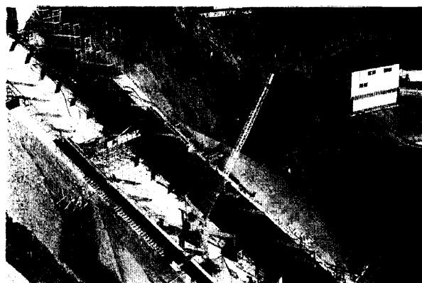
写真-2 ジブクレーンによる施工状況
