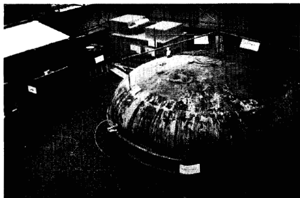
写真-1 AWJによる作業状況
