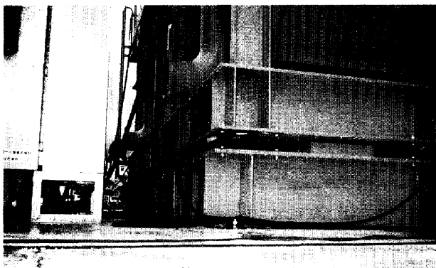
写真-3 エアーダンパ (防振架台)
