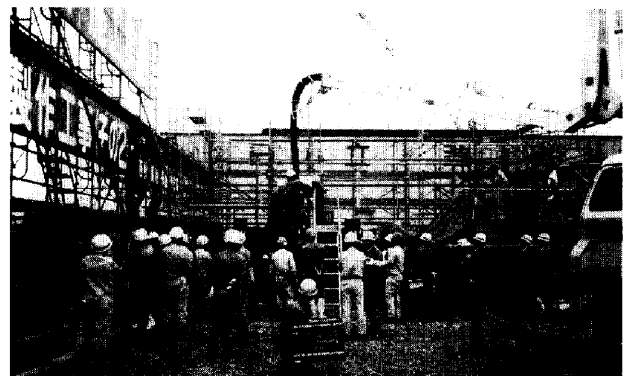
写真-1 試験施工の状況
