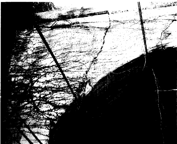
写真-2 坑門工クラック状況（クラック幅は30～50mm）
