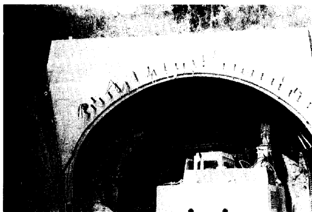
写真-4 坑門補強及び長尺先受工
