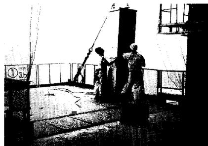
写真-18 構台とパネル吊込み
