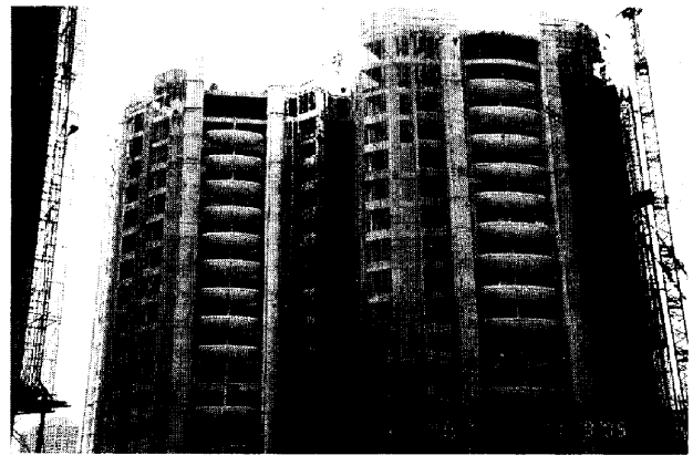
写真-6 BLOCK 5取付完了時全景
