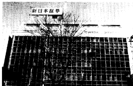
写真-2 改修後の外観
