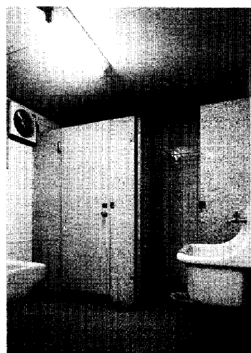
写真-3 改修前のトイレ
