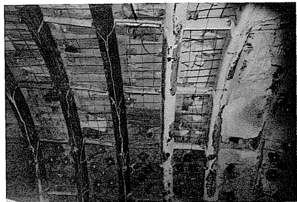
写真-2 仮巻き支保工
