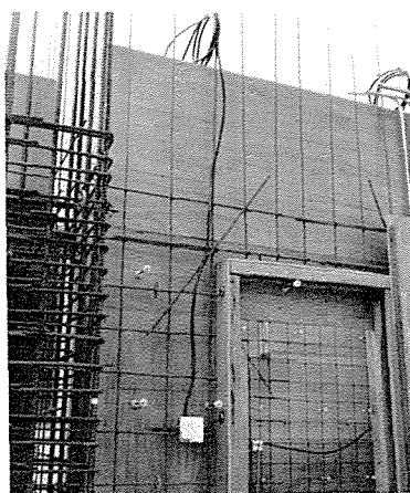
写真-3 壁内立上り配線
