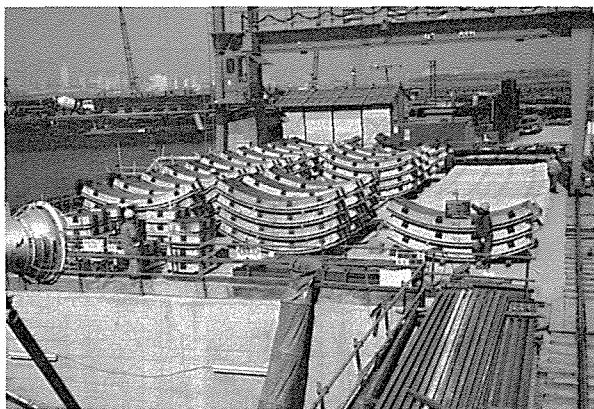
写真-6 セグメントストックヤード
