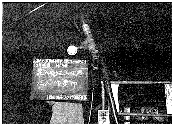
写真-8 裏込注入作業
