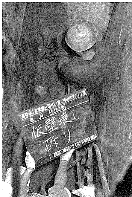
写真-3 エントランス仮壁こわし作業
