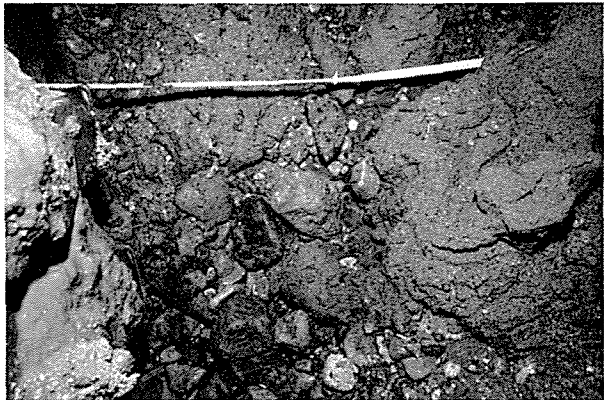
写真-2 切羽状況（下半砂礫層）
