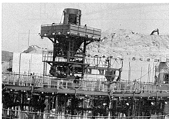
写真-7 回転移動式コンクリート打設機械
